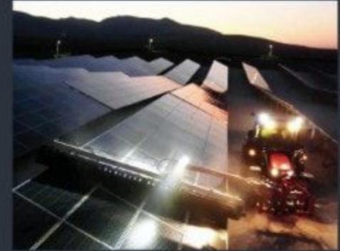
En doğru yıkama zamanı panel üzeri ıslak derecesi ile yıkama sıvısının ısı derecelerinin birbirlerine en yakın olduğu zamanlardır. Yazın özellikle saat 10.00 ile saat 17.00 arası yıkama yapılmamalıdır. Paneller üzerindeki şiddetli ısı farkı panellere zarar verir.
